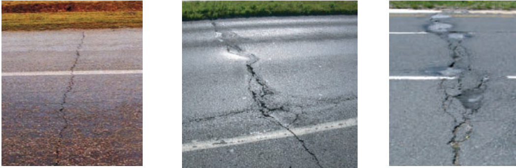
Abb. 2.3 Typische Schadensbilder für Reflexionsrisse (Bennert und Maher, 2008; Rathmeyer, 2007)
