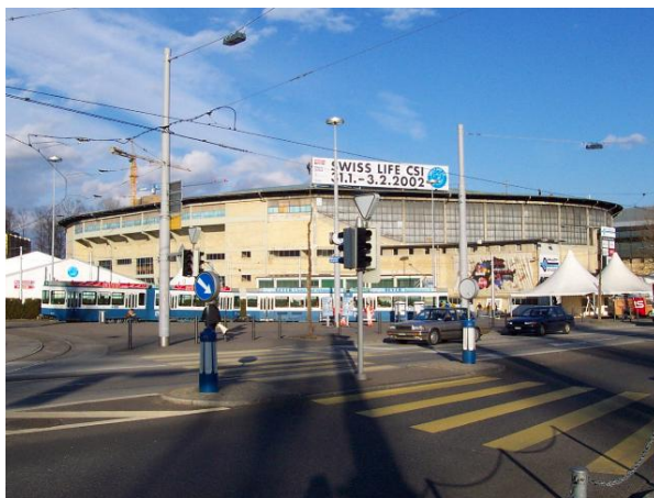
Ansicht aus Nordwesten
