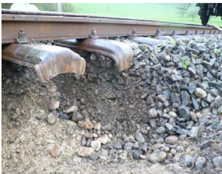
Abb. 1: Aufbau des Oberbaus der DVZO
