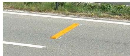
Abbildung 16: Beispiele von kleineren Verschiebungen der Warnschwelle
