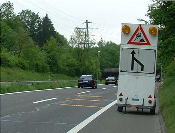
Abbildung 13: Zusatzsignal bei neuer Versuchsanordnung an der Tagesbaustelle A53-Uster (Abbau des Normalstreifens)
